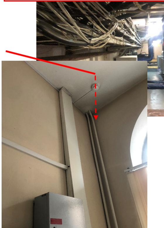
**Рис.6.** Трасса магистральных лотков и опуск КЛ в помещение диспетчера.
